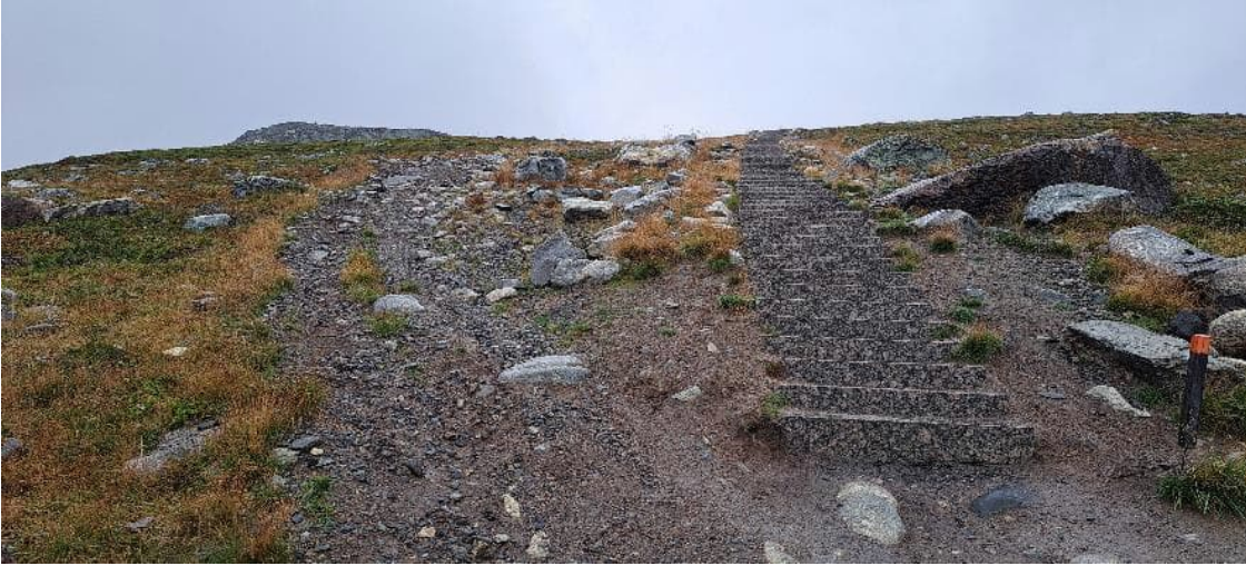
Kuva 2 Portaat helpottavat kulkua ja saavat kävijöitä pysymään reitillä. Saanan huipulle vievä, Natura-alueen ulkopuolella oleva reitti.
